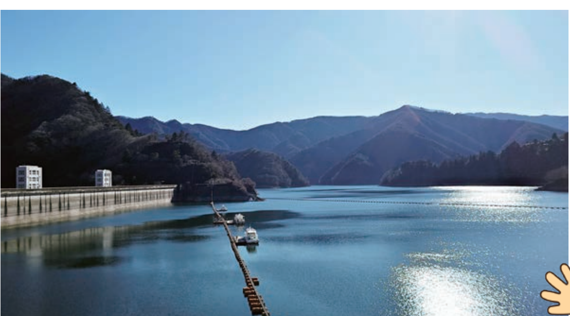
おごうち 小内ダム（東京都西多摩郡奥多摩町） 小内ダムは水道せん用のちよ水池ですが水力はつ電にも用いています。
